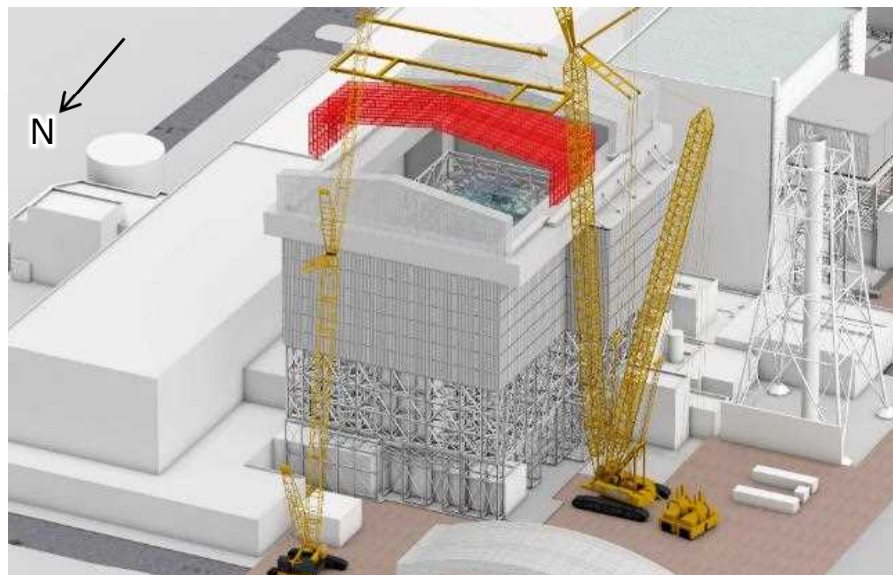
可動屋根設置中
