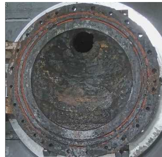
X-6ペネ内部の状況（フランジ面レーザ清掃後）
