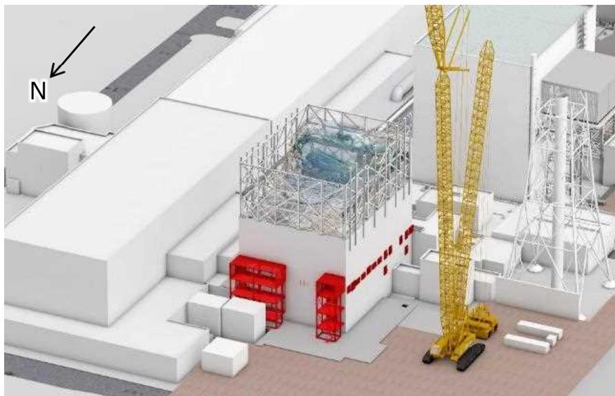
仮設構台部アンカー・ベースプレート設置中 (現在)
