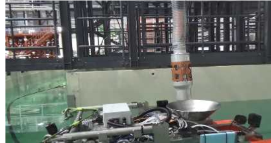
移送ホース (地下階接続作業)
