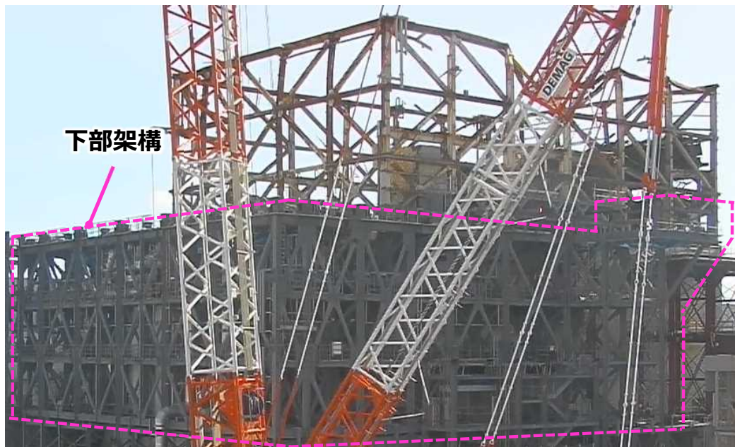
現場状況 (北西面) (撮影：2024年1月24日)
