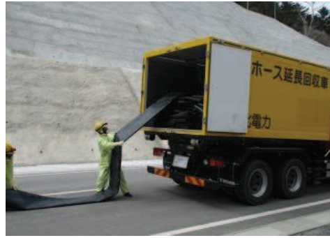
ホース敷設, 接続 (屋外)
