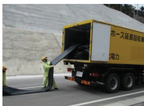
ホース敷設，接続
