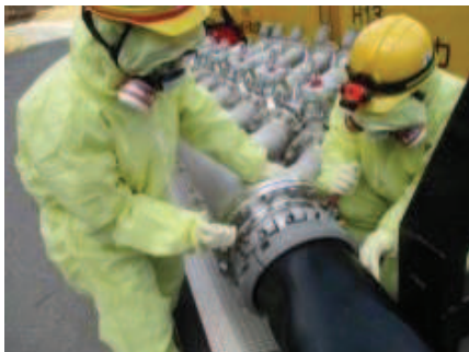
注水用ヘッダへのホース接続
