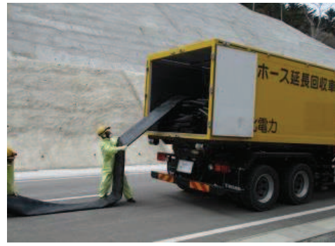
ホース敷設, 接続 (屋外)
