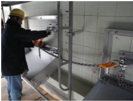
レバーブロック操作
