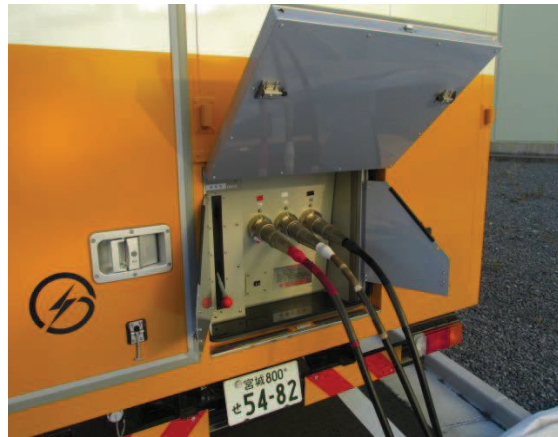
電源車ケーブル接続
