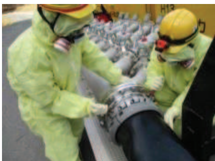
注水用ヘッダへのホース接続
