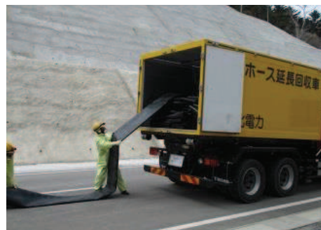
ホース敷設，接続
