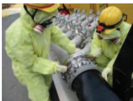
注水用ヘッダへのホース接続
