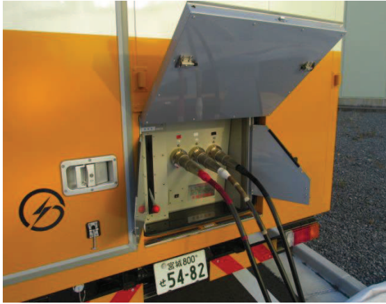
電源車ケーブル接続
