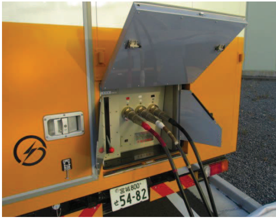
電源車ケーブル接続
