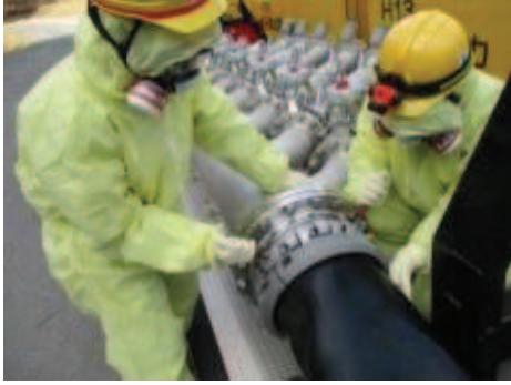
注水用ヘッダへのホース接続
