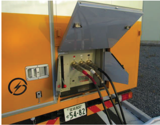
電源車ケーブル接続
