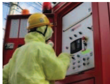
大容量送水ポンプ（タイプ I）の起動
