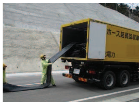
ホース敷設、接続
