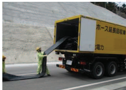
ホース敷設，接続
