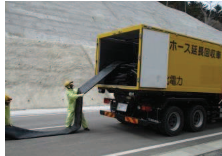
ホースの敷設、接続
