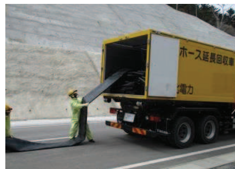
ホース敷設、接続
