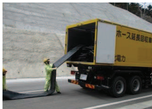
ホースの敷設、接続
