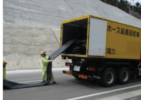
ホースの敷設，接続
