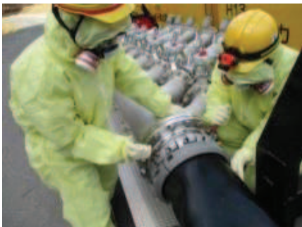
注水用ヘッダへのホース接続
