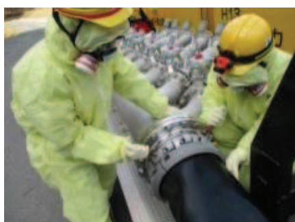
注水用ヘッドへのホース接続
