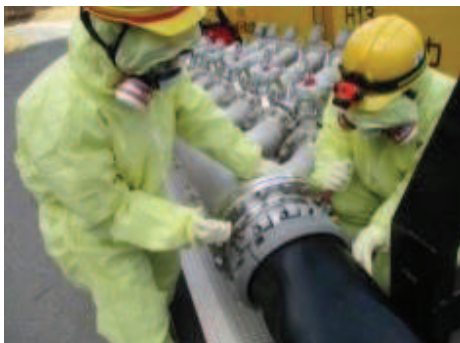
注水用ヘッダへのホース接続
