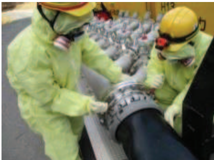
注水用ヘッダへのホース接続
