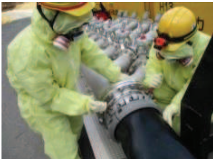
注水用ヘッダへのホース接続
