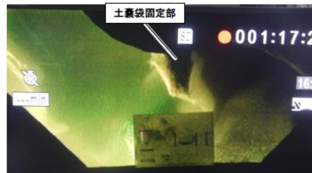
劣化土嚢袋（吸引中）の状況
