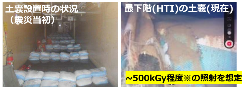
ゼオライト土嚢袋の現場状況
