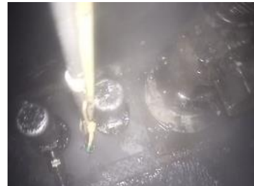
建屋最下階におけるスラッジ等の洗浄時
