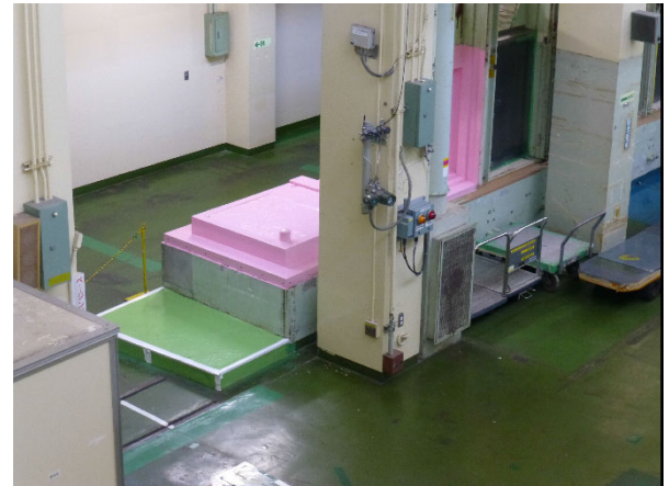
鉛セル解体撤去
