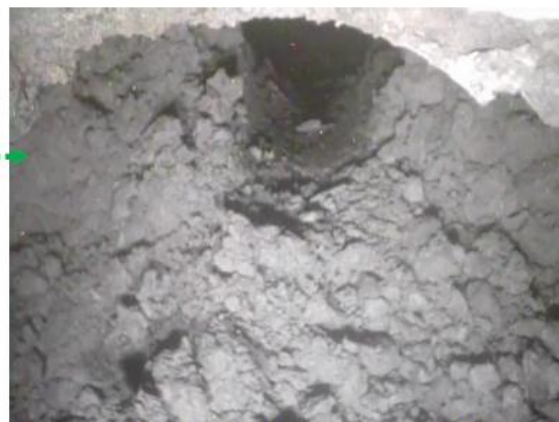
低圧水施工前 1月17日作業開始前
