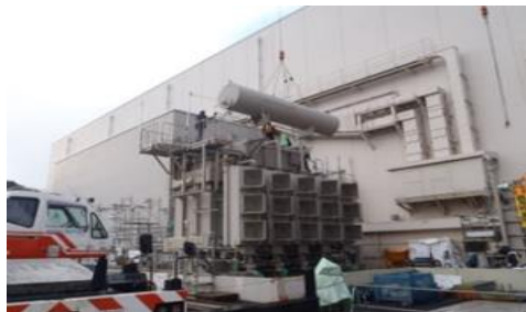
撤去作業の状況
