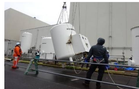
撤去作業の状況
