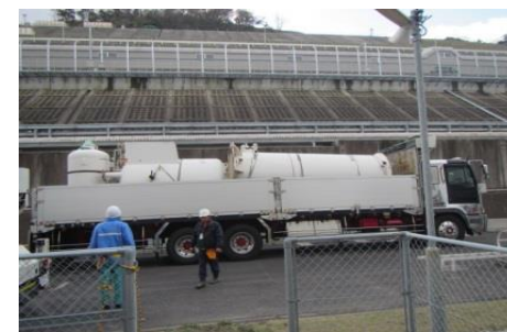
解体物の移送
