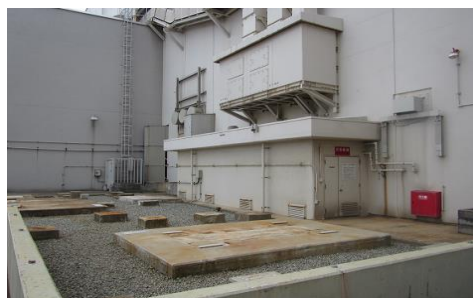
撤去作業後の状況
