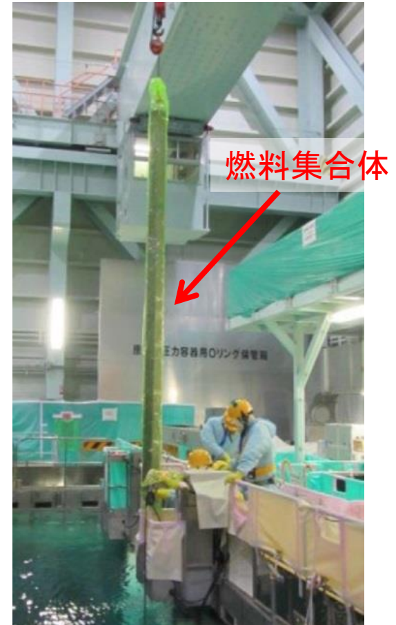
新燃料の引き上げ状況
