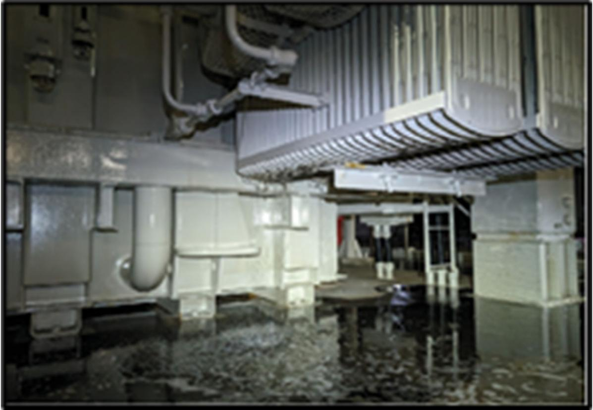
图2. 1号機 起動変圧器 漏油状況
