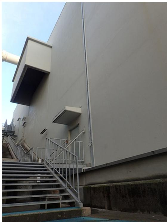
図2. エキスパンションジョイントカバーの脱落状況（2）
