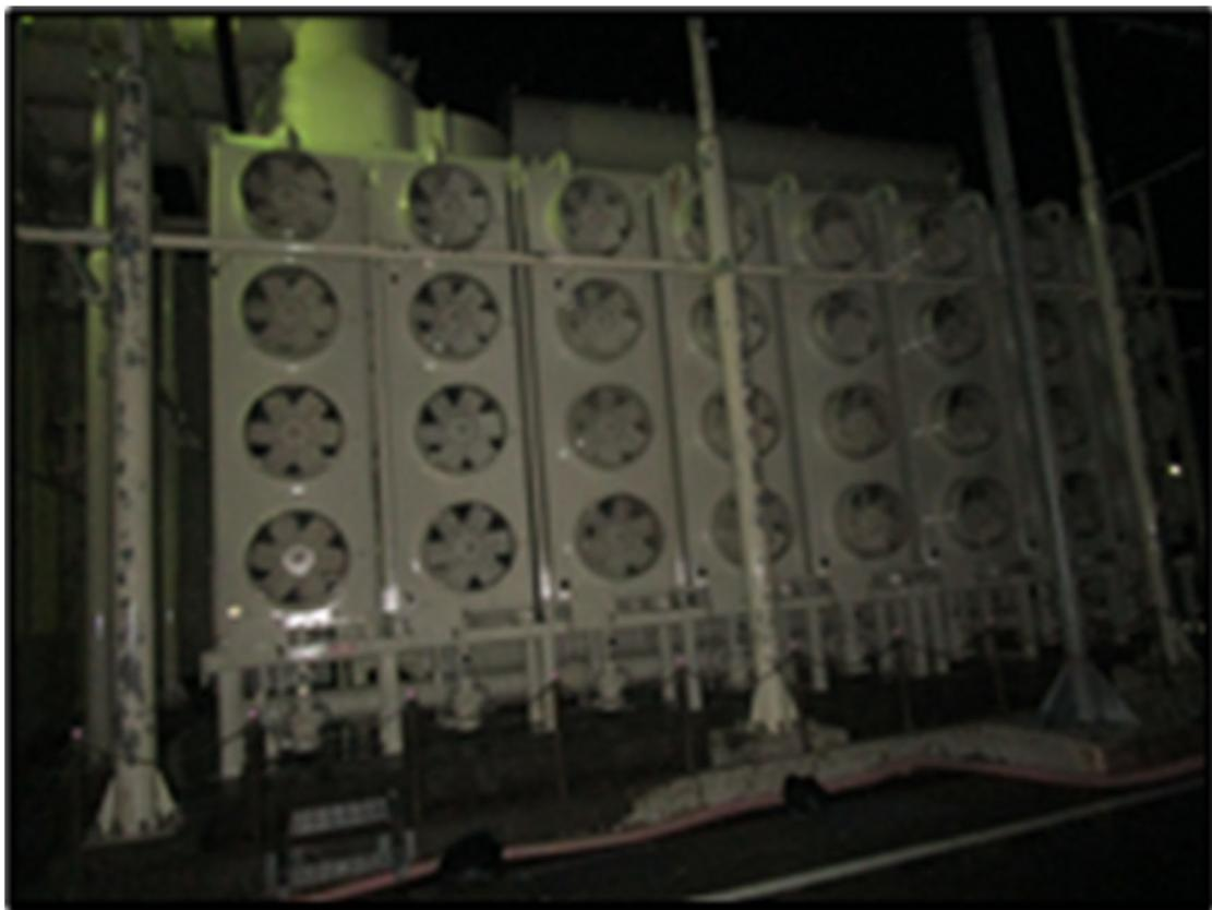
図 2. 2号機主変圧器 漏油状況
