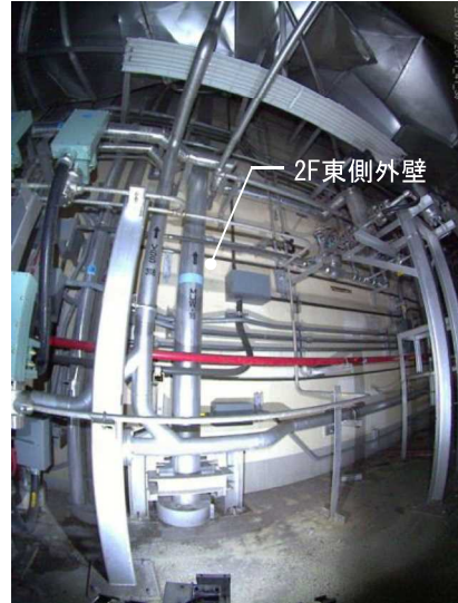
④2F東側外壁
