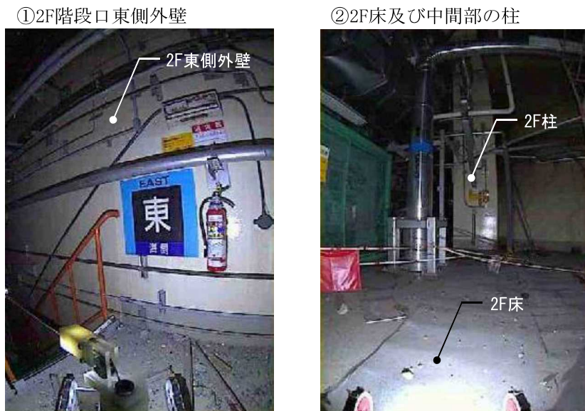
図-2.4(1) 建屋内状況写真（2階）
