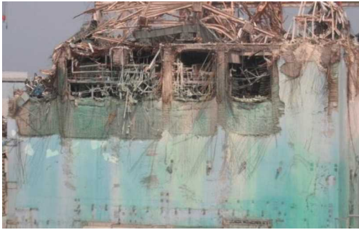
②東側壁面
