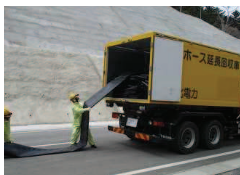
ホース敷設，接続
