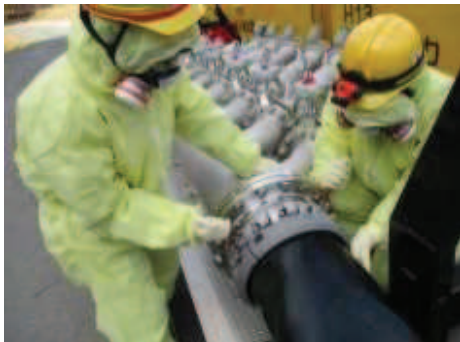
注水用ヘッダへのホース接続
