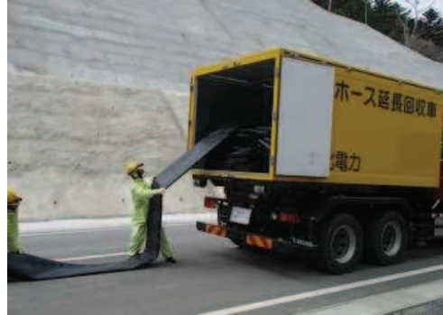
ホースの敷設、接続
