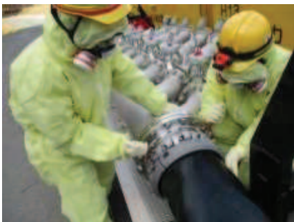
注水用ヘッダへのホース接続
