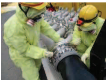
注水用ヘッダへのホース接続
