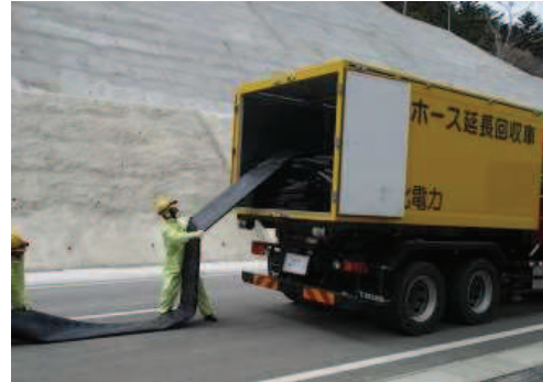
ホースの敷設、接続
