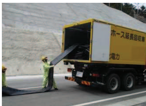
ホース敷設, 接続 (屋外)
