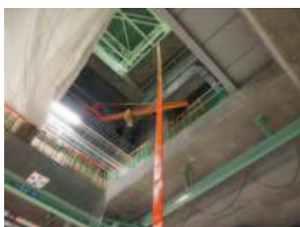
ホース敷設, 接続 (屋内)
