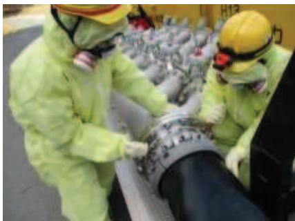
注水用ヘッダへのホース接続
