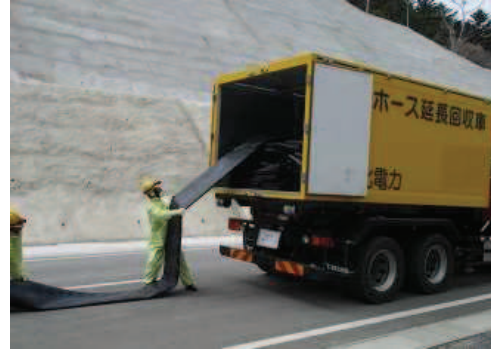
ホースの敷設，接続
