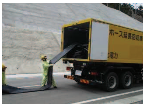
ホース敷設, 接続 (屋外)
