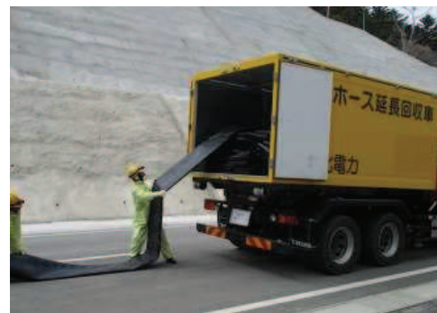
ホース敷設, 接続
