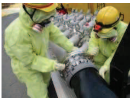
注水用ヘッダへのホース接続
