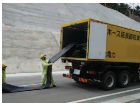
ホース敷設，接続
