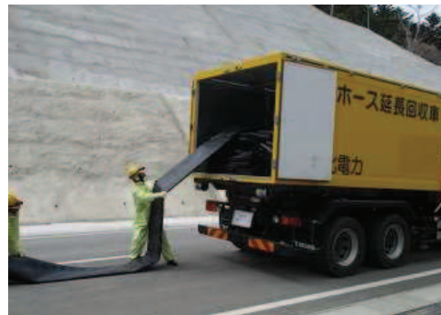
ホース敷設，接続
