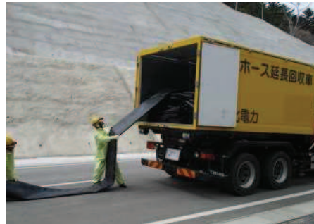
ホースの敷設、接続
