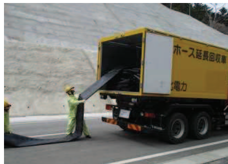
ホース敷設, 接続
