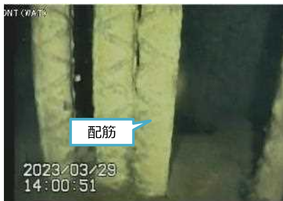
写真2. ポイント⑫ペDESTAL基礎部
