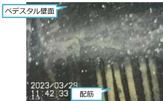
写真1. ポイント⑪ペDESTAL基礎部
