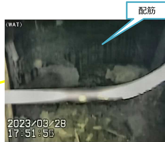
写真1. ポイント⑧ペDESTAL基礎部
