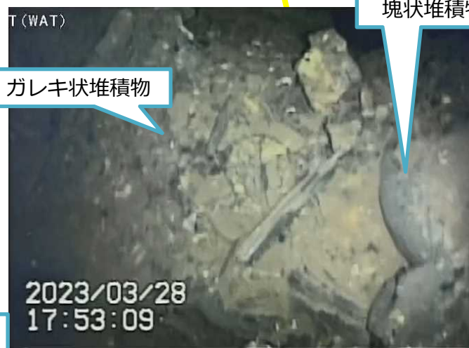
写真3.ペDESTAL内開口付近堆積物
