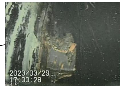
サポートプレート (18個) サポートプレートとレイル
