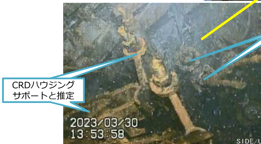
写真1. CRDハウジングサポートと思われる構造物
