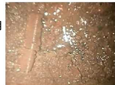
2号機ペDESTAL底部の状況 (2018年PCV内部調査)
