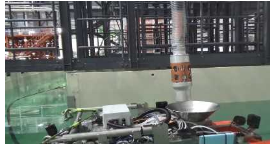
移送ホース (地下階接続作業)
