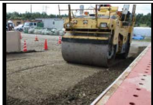
施工状況(予備試験)
