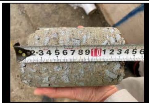
覆土材料(施工後コア)
