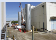
工事途中外観（R5.5月撮影）
