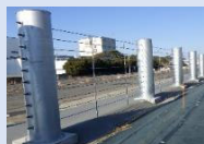
設置完了（R5.1月撮影）
