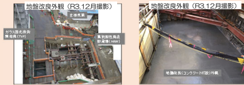
工事実績：R2.8月～
