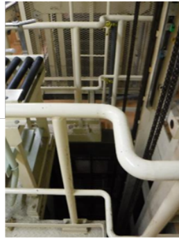
床（カートン搬出リフトの開口部）
