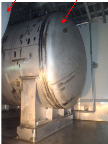
受入貯槽(328V10)の設置状況 (側面)
