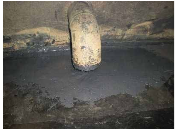
底板ドレン配管近傍
