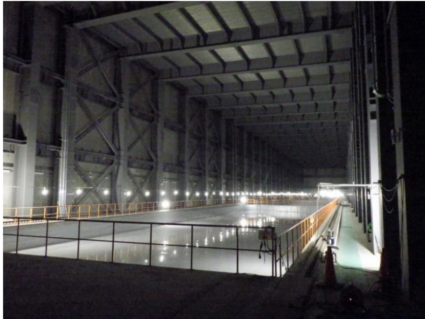
図 1-3 大型廃棄物保管庫内全景（2023 年 1 月時点）
