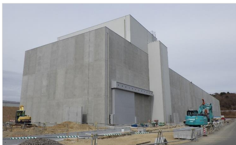
図 1-2 大型廃棄物保管庫全景（2023年2月時点）
