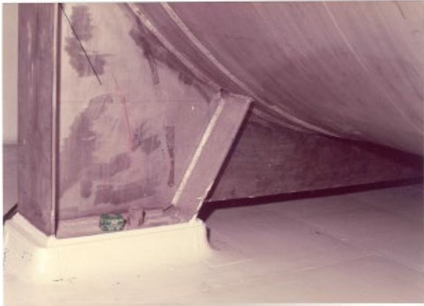
廃希釈剤貯槽（318V10）の下部
