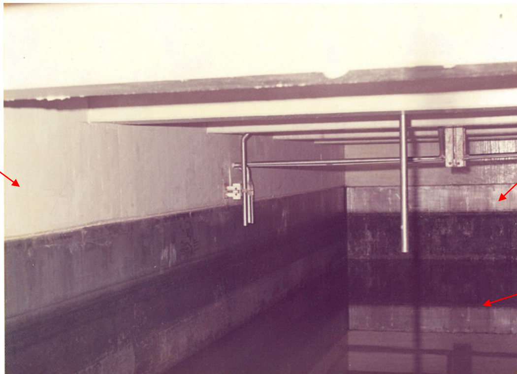
低放射性廃液貯槽(R012)の設置状況
