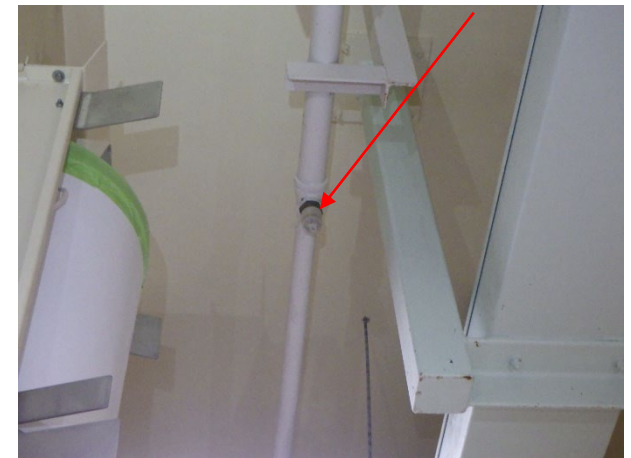
カートン貯蔵施設(A001)の天井
