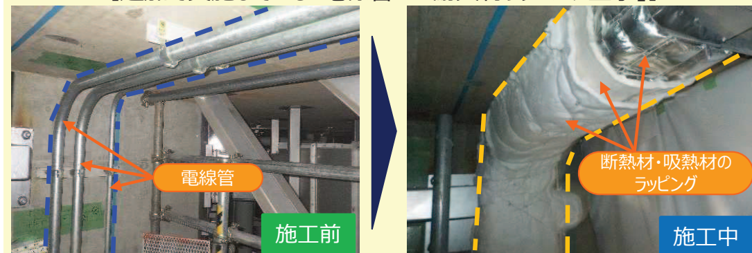
【追加で実施している「電線管への耐火材ラッピング工事」】
