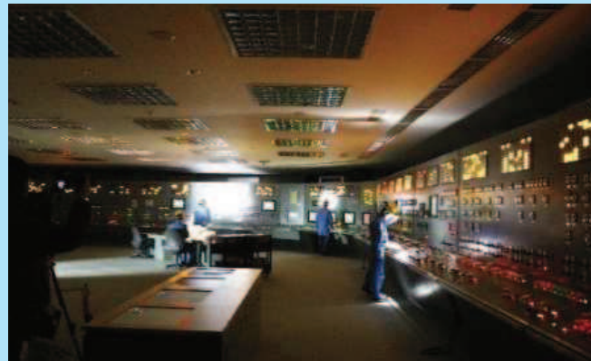
全交流電源喪失を想定した運転訓練 （運転シミュレータ訓練施設）
