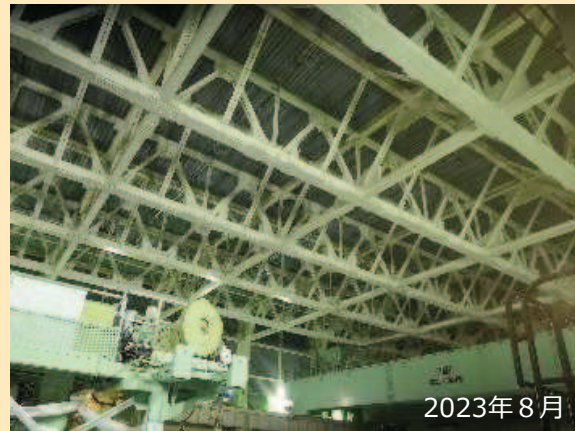
【耐震補強工事（原子炉建屋上部）】
