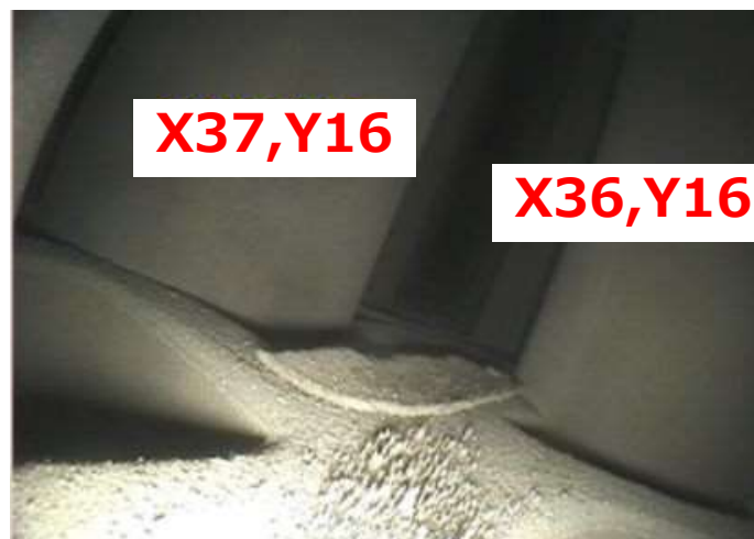
A-SG 第一管支持板上写真
