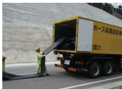
ホース敷設、接続
