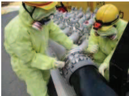
注水用ヘッダへのホース接続
