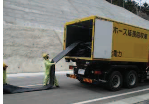
ホースの敷設、接続
