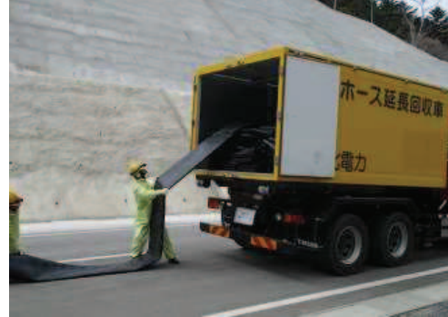
ホースの敷設，接続
