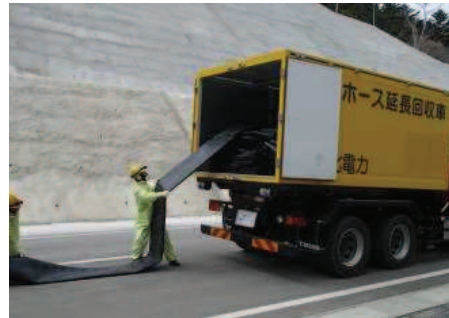
ホースの敷設、接続
