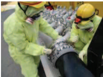
注水用ヘッダへのホース接続
