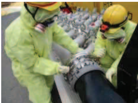
注水用ヘッダへのホース接続
