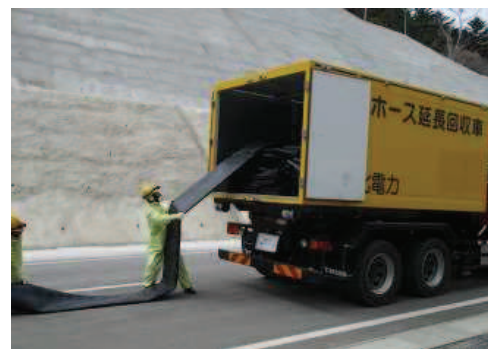
ホース敷設, 接続
