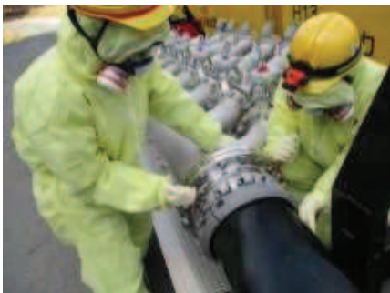
注水用ヘッダへのホース接続
