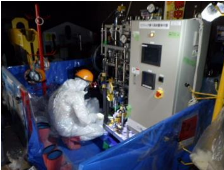
フィルタ通水試験装置写真
