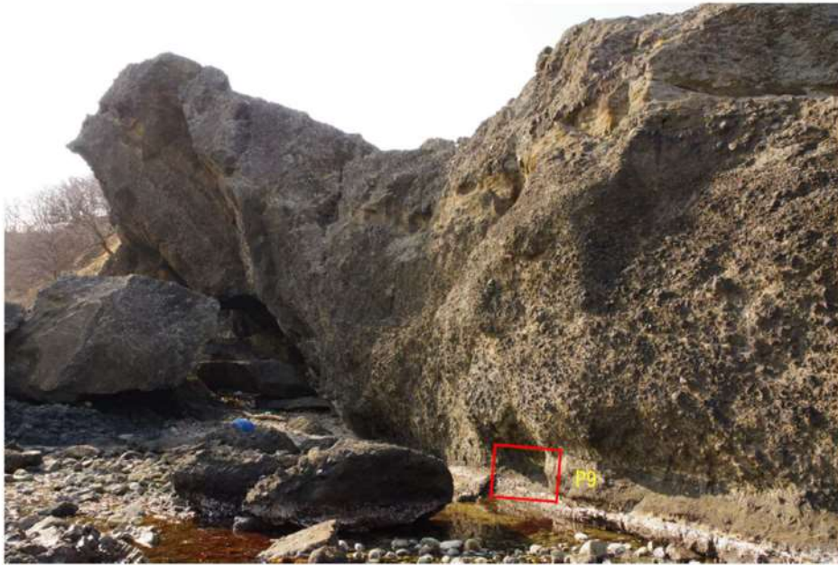
図 2.1. a. c-4 (8) 防潮堤 (茶津側) 露頭状況 P8 岬突端部
