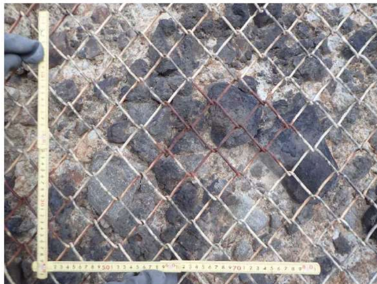
図 2.1.a.c-7 (2) 防潮堤（堀株側）露頭状況 P2 防潮堤擦り付け部（P1 拡大） 凝灰角礫岩が分布し、B 級からなる。
