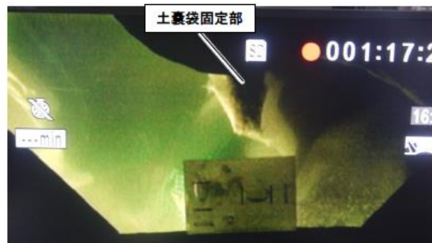
土囊袋（吸引中）の状況
