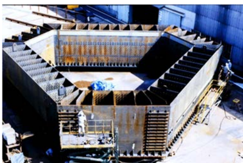
写真2-4 生体しゃへい壁の鋼製枠組み
