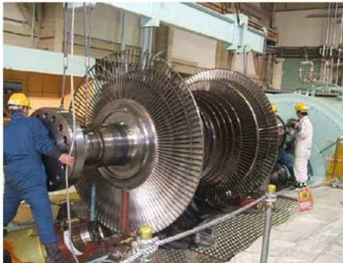
写真3-5 タービン点検の様子
