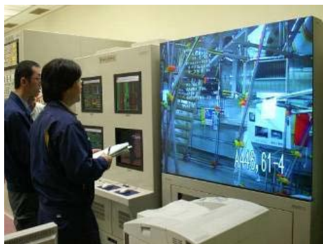
写真11-1 総合漏えい監視システム
