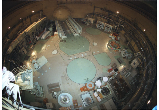
原子炉格納容器内部( 緑 視)
