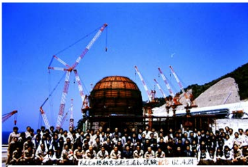
写真2-3 大型サイドクレーン（背後左）とタワークレーン（右）
