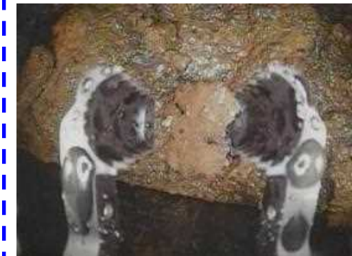
プラットフォーム上堆積物の把持状況 (概要図①の付近)
