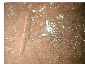
2号機ベデスタル底部の状況 (2018年PCV内部調査)
