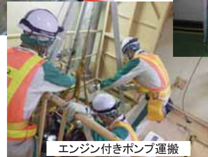
エンジン付きポンプ運搬
