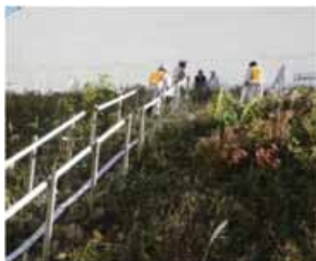
法面でのホース敷設
