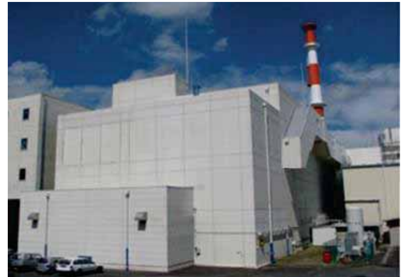
プルトニウム転換技術開発施設 外観
