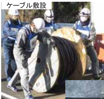
ケーブル敷設
