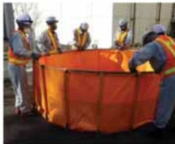
組立式水槽の設置
