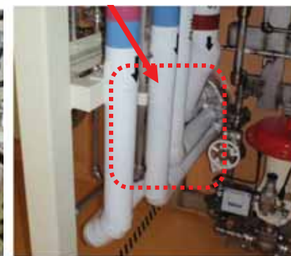
複数本の蒸気配管の壁貫通部
