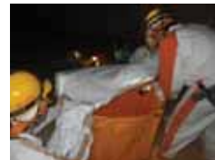
⑧給水作業
