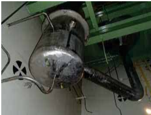
低放射性廃液第二蒸発缶
