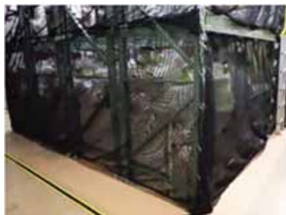
廃棄物保管棚へのネットの設置
