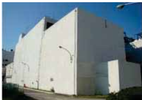
アスファルト固化処理施設外観
