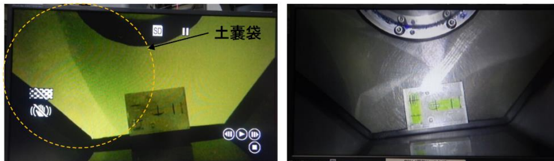
カメラを搭載した吸引ノズルによる監視状況
