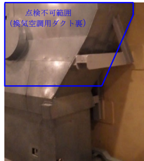
図3. 10 点検不可範囲の例（換気空調用ダクト裏）（高浜4号炉の写真）
