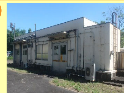
廃液長期貯蔵施設(R7~R9作業予定)
