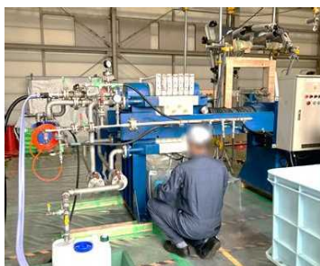
脱水処理(圧搾工程)
