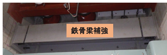
鉄骨梁補強箇所(天井パネル内)
