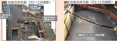
工事実績：R2.8月～
