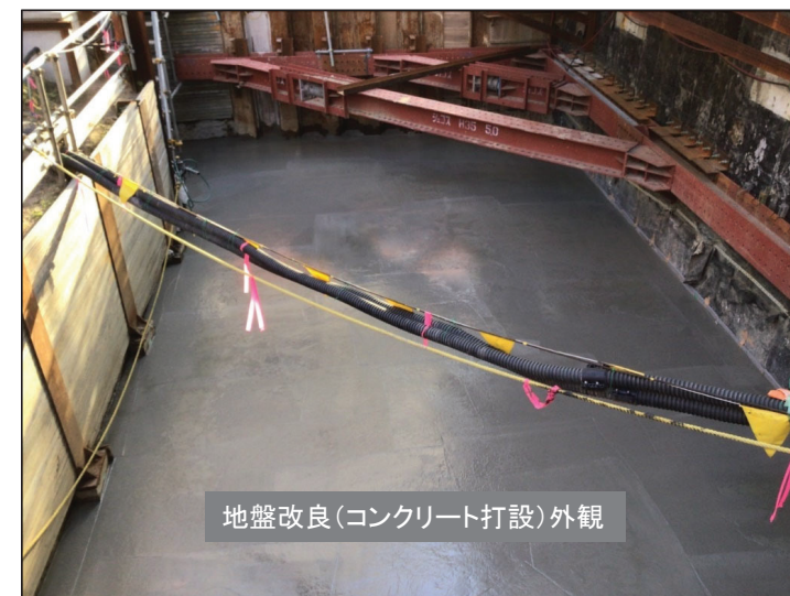
地盤改良工事の状況(令和3年12月)
