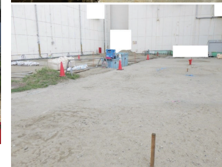
地盤改良後(R4年7月撮影)
