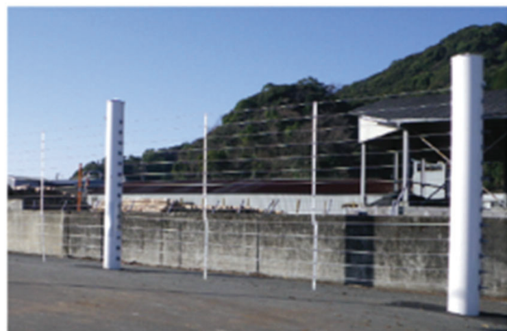
津波漂流物防護柵の設置イメージ
