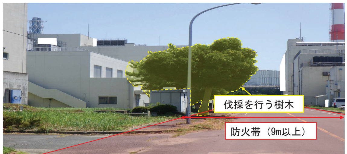
防火帯設置場所の現況
