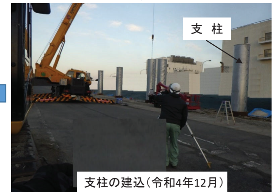
津波漂流物防護柵(引き波)の設置工事の進捗状況(令和5年1月)
