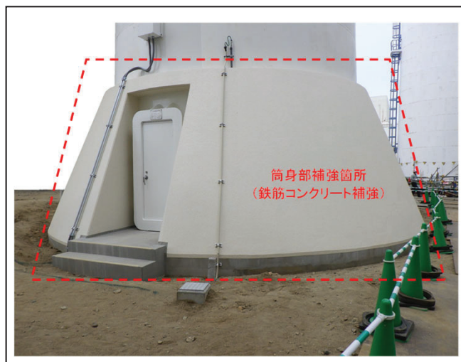
図1 第二付属排気筒の耐震補強
