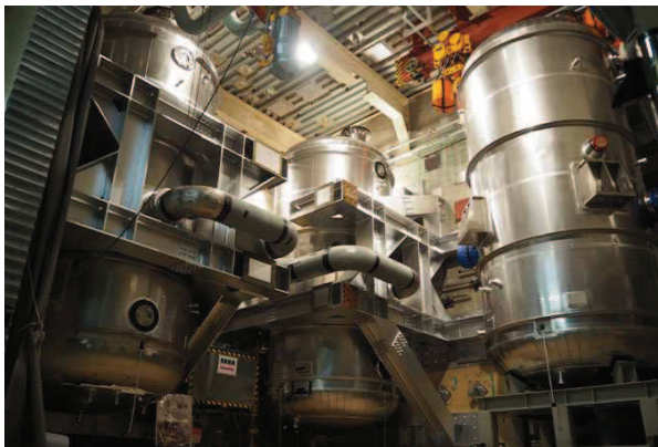
原子炉建屋への据付状況
