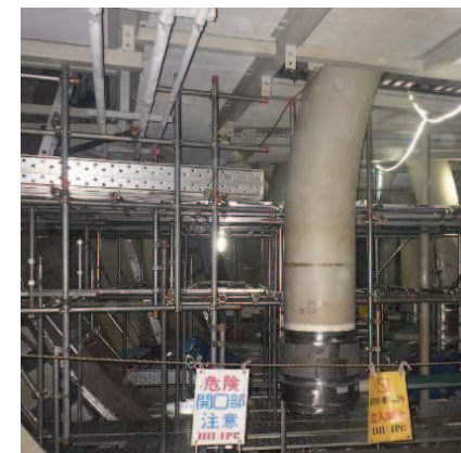
内部の工事状況
