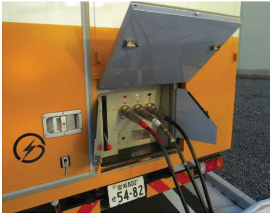
電源車ケーブル接続
