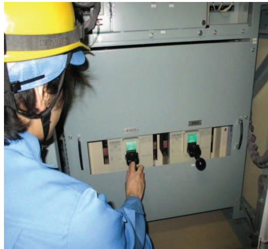
125V 代替蓄電池の切操作
