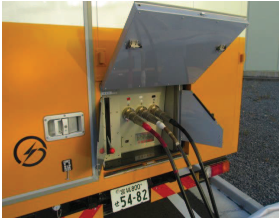
電源車ケーブル接続
