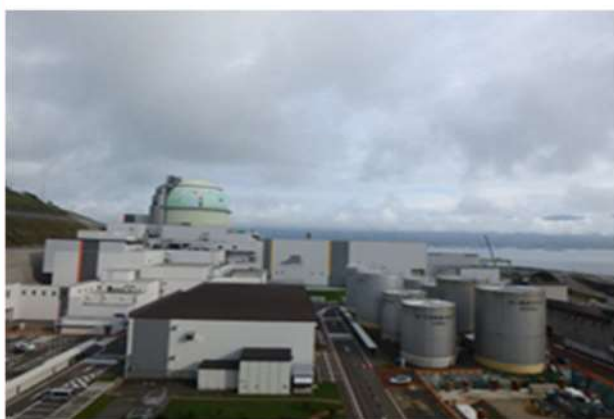
2号炉タービン建屋屋上
