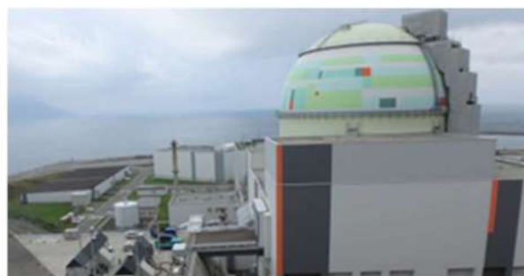
3号炉北東法面
