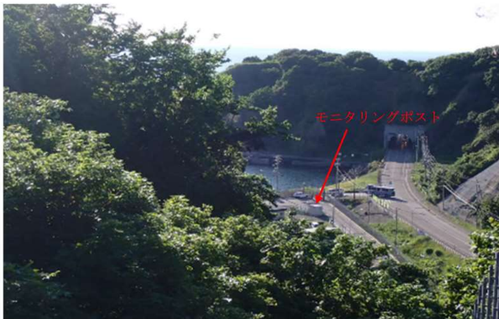
(4) 構内監視カメラ（茶津守衛所付近）から急傾斜地崩壊危険箇所
