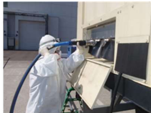
高圧ケーブル接続 (コネクタ) (屋外)
