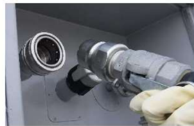
代替非常用発電機の給油口へのホース接続（クイックカップラ式） （代替非常用発電機） （屋外）
