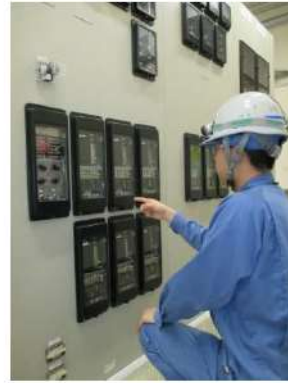
保護リレーロック操作 (1号炉2次系継電器室) (原子炉補助建屋T.P. 9.8m)
