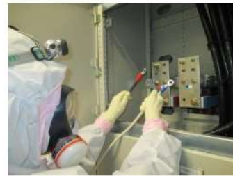
可搬型直流変換器 直流出力ケーブル接続(端子) (安全補機開閉器室) (原子炉補助建屋T. P. 10. 3m)
