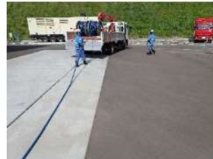
号炉間連絡予備ケーブル敷設（屋外）
