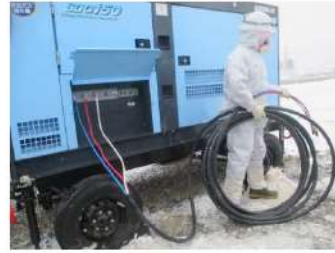
可搬型直流電源用発電機ケーブル敷設 (屋外)
