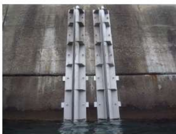
荷揚場シルトフェンス固定金具
