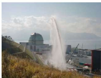
第2図 直線状放射による放水状況
