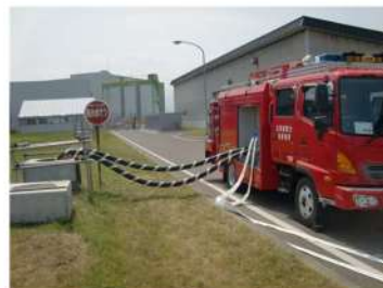
水源への吸管挿入 (屋外)
