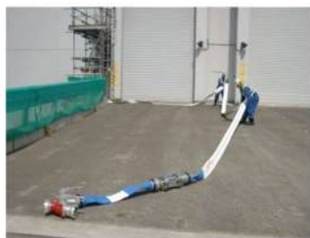
可搬型ホース敷設 （屋外）
