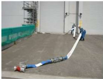
可搬型ホース敷設 （屋外）
