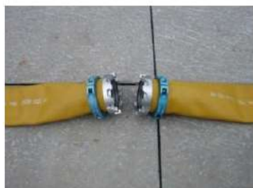
可搬型ホース(150A)接続前
