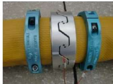
可搬型ホース (150A) 接続後
