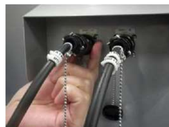
検出器用ケーブル接続
