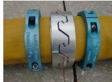
可搬型ホース(150A)接続後
