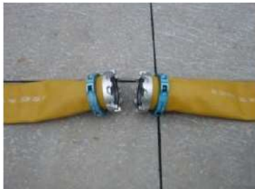
可搬型ホース(150A)接続前
