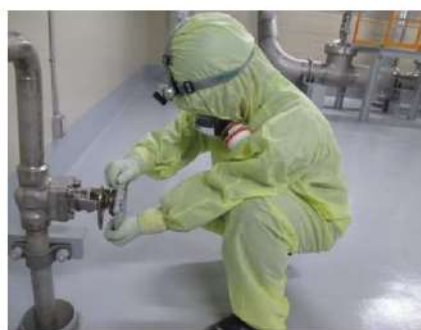
2次系補給水ポンプによる注水 (周辺補機棟 T.P. 10.3m（中間床）)
