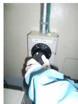
電源ケーブル接続
