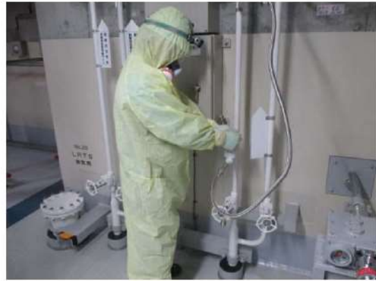
(制御用空気供給弁閉操作イメージ)
