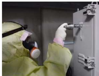
可搬型アニュラス水素濃度計測ユニットの接続 (周辺補機棟 T. P. 24. 8m)
