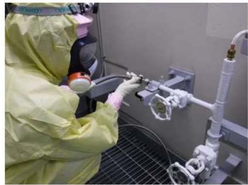
代替空気(窒素)供給用フレキシブル配管接続 (周辺補機棟 T. P. 17. 8m (中間床))
