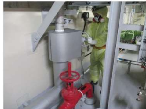
代替格納容器スプレイポンプ系統構成 (原子炉補助建屋 T.P. 10.3m)
