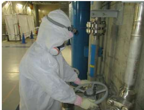
原子炉容器から原子炉格納容器への切り替え 系統構成 (周辺補機棟 T. P. 10. 3m)
