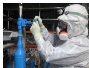
原子炉補機冷却水系加圧操作 (周辺補機棟 T. P. 43. 6m)
