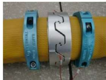
可搬型ホース（150A）接続後
