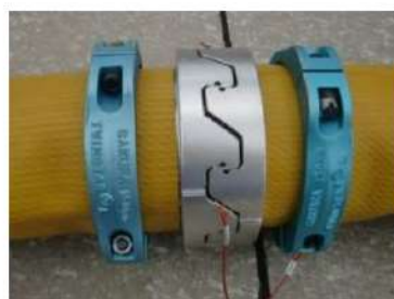
可搬型ホース(150A)接続後
