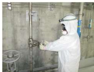
可搬型大型送水ポンプ車による原子炉 格納容器内へのスプレイ系統構成 （運転員（現場）C） （周辺補機棟 T. P. 10. 3m）
