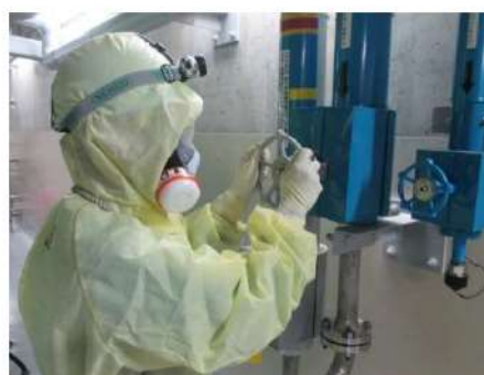
B-格納容器スプレイポンプ (自己冷却)原子炉格納容器内へのスプレイ 系統構成 (原子炉補助建屋 T.P. -1.7m)
