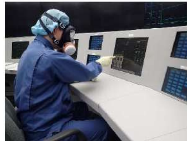
主蒸気逃がし弁開操作 (中央制御室)
