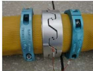
可搬型ホース（150A）接続後
