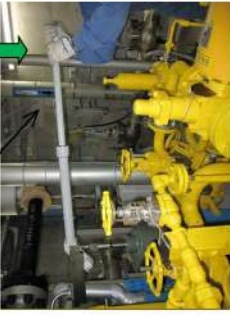
起動レバー (約 10 kg) 押し下げる
