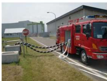
可搬型大型送水ポンプ車の設置 代替給水ピットへの吸管挿入 (屋外) (作業風景は類似作業)
