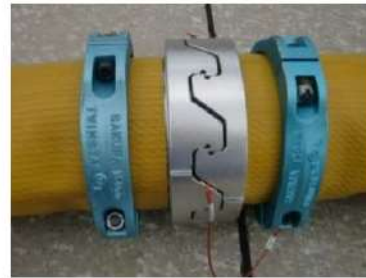
可搬型ホース(150A)接続後
