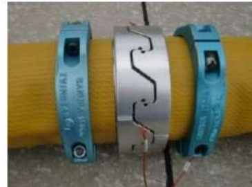
可搬型ホース(150A)接続後
