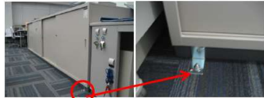
図11 キャビネットの固定
