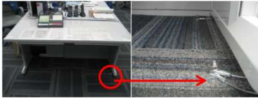
図10 運転員机の固定
